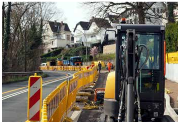
Baustelle Simmerner Straße Hbf - Karthause
