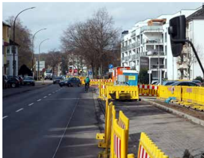
Baustelle Radstreifen Beatusstraße als Verbindung Hbf – Gülsler Brücke
